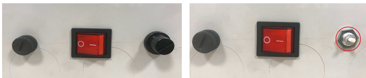
Obr. č. 39 – STB havarijní termostat
